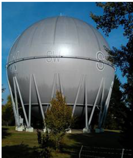
Рис. 3. Газгольдер для хранения газа, получаемого газификацией угля (фото автора).
