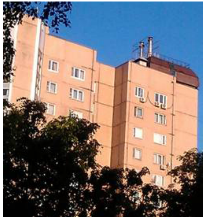
Рис. 12. Работаящая котельная на крыше московского дома (фото автора).
