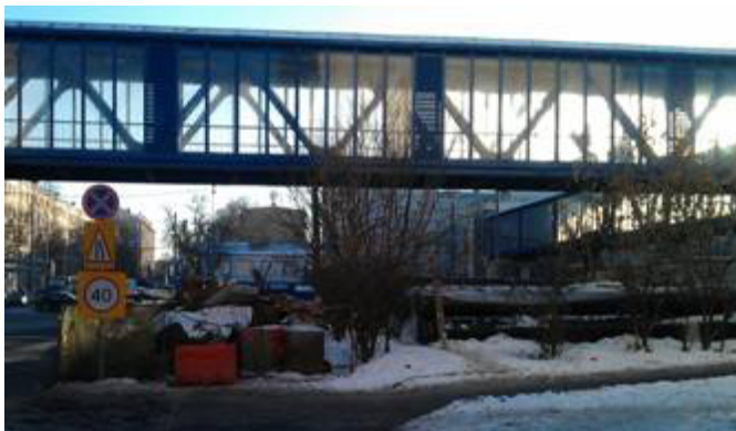
Рис. 6. Ремонт теплосети с созданием транспортных про- блем (фото автора).
