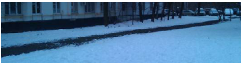
Рис. 7. Участок теплосети с плохой теплоизоляцией (фото автора).
