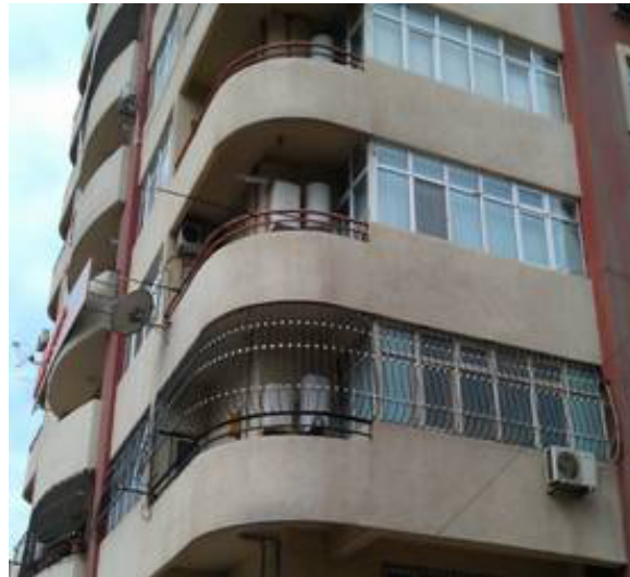
Рис. 15. Балконы жилого дома с газовыми котлами для отопления и ГВС квартир (фото автора).
