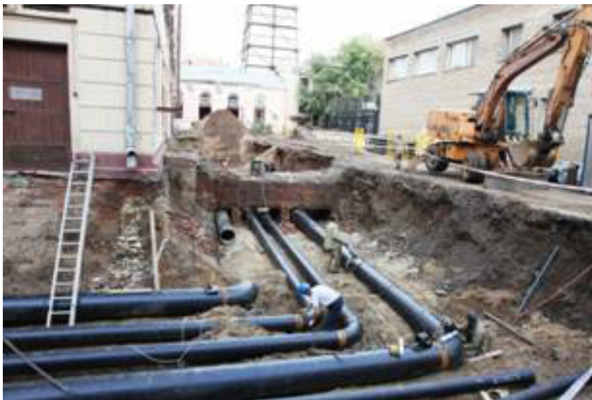
Рис. 8. Этап реконструкции ТЭЦ МЭИ – замена труб теплосети (фото с сайта энми.рф).
